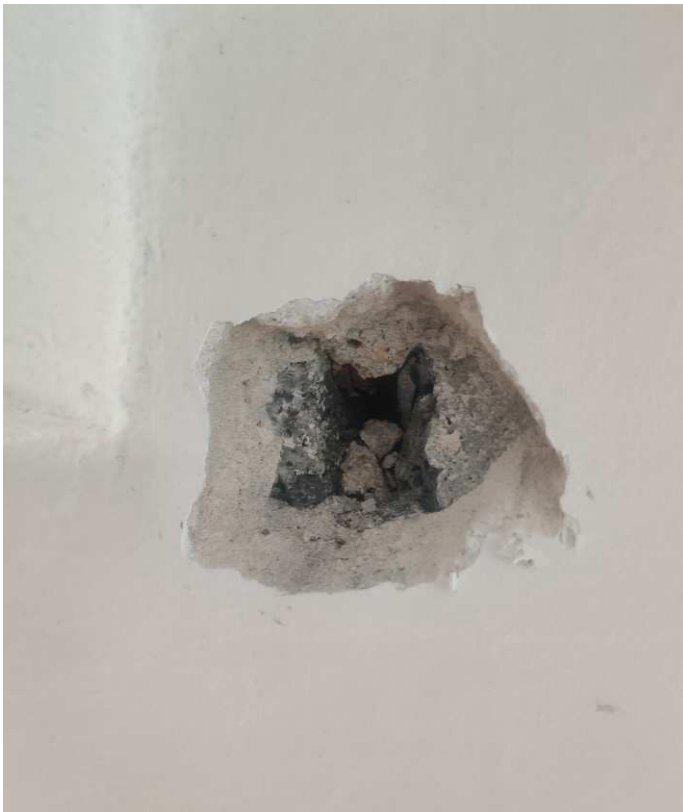
fot.5. Odkrywka murowanej z pustaków żużlobetonowych ściany.
