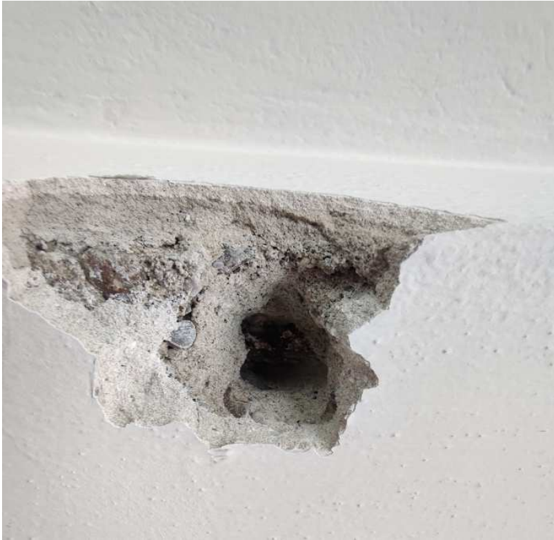
fot.4. Odkrywka zbrojenia żebra stropowego.
