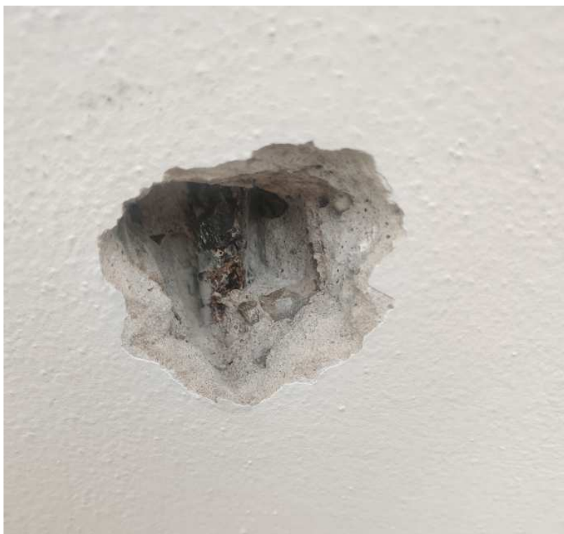
fot.4. Odkrywka zbrojenia płyty stropowej.
